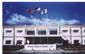
Hitachi Air Conditioning, Филиппины
